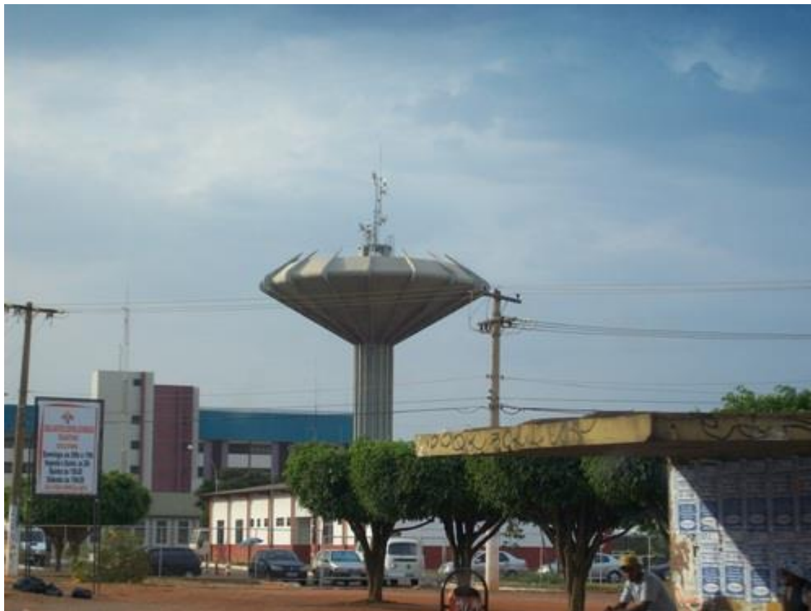
FIGURA 9- Caixa d'água em Taguatinga
