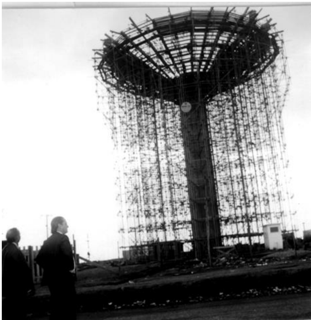
FIGURA 7- A Construção da Caixa d'água
