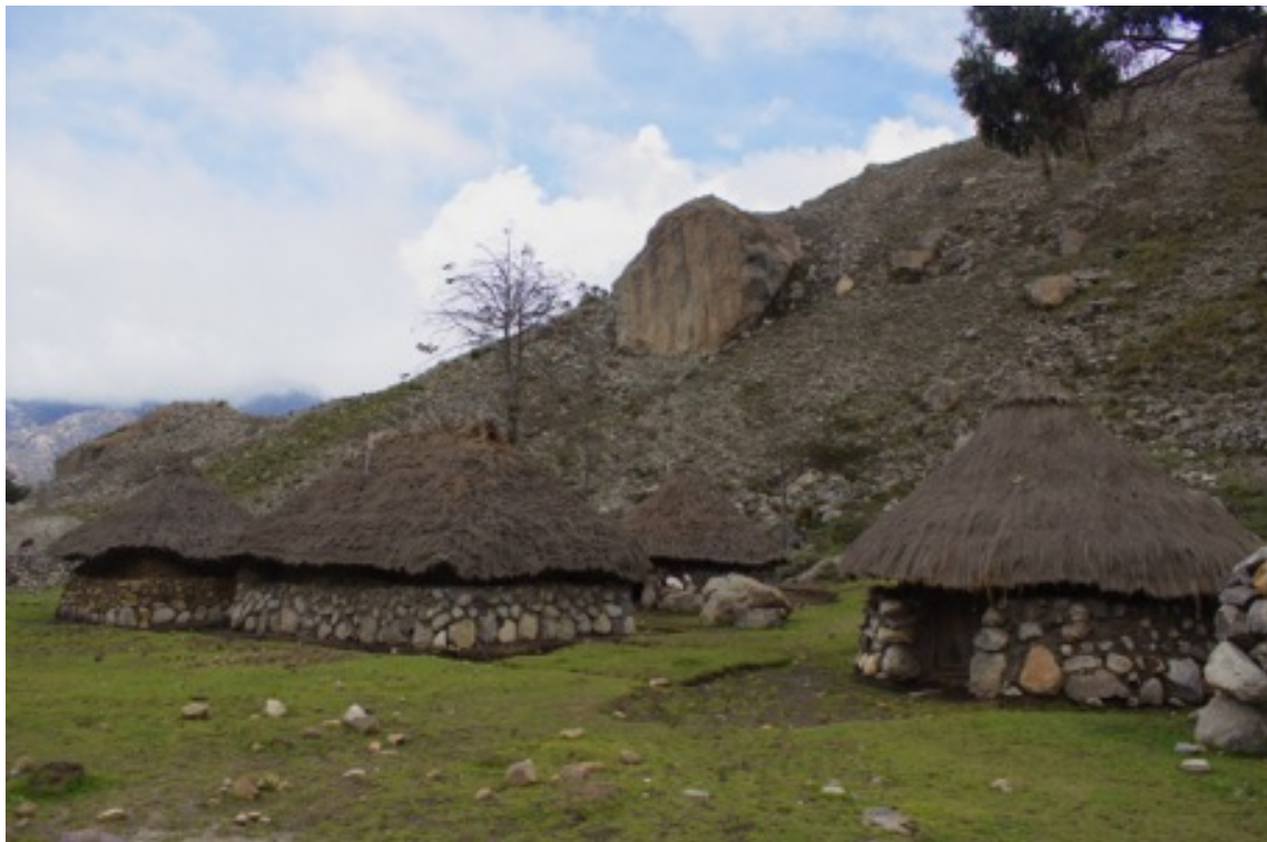
Casas con murallas de piedra para resguardarse del frío intenso. Fuente: Archivo personal, 2015
