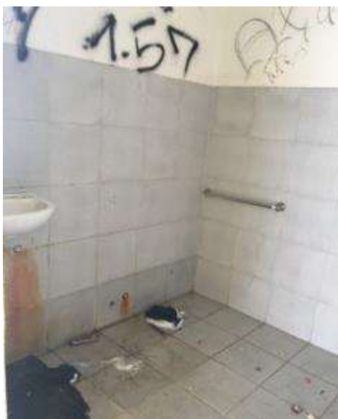
Figura 30 - Banheiro para PCD do salão de festas do Pitangueiras II
