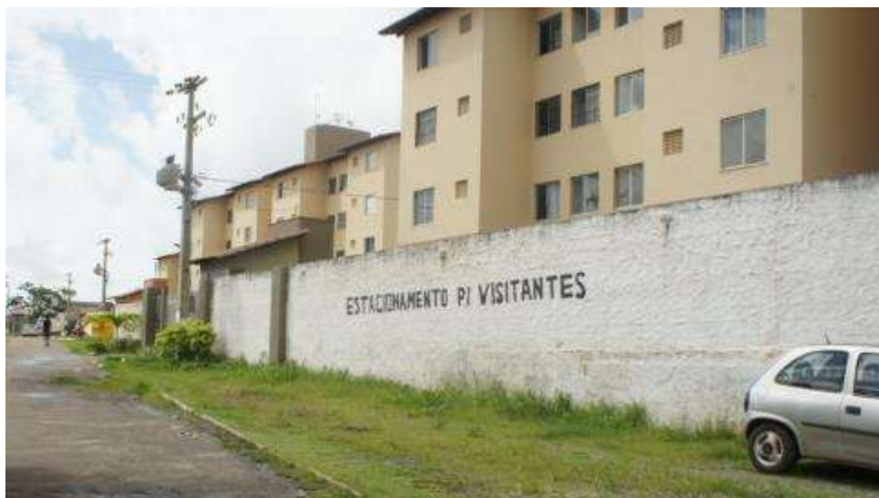
Figura 35 - Estacionamento para visitantes na área externa do conjunto
