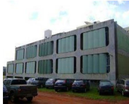
Figura 2: Fachada Sul HEMODF.
