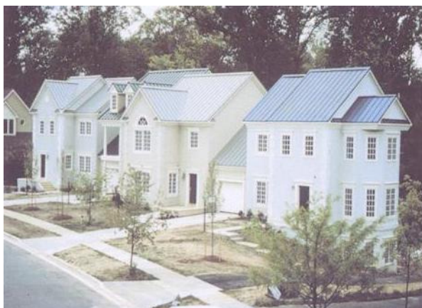
Figura 2.29 – Aplicação de filme fino de silício amorfo em telhado de residência. (fonte: Rütther, 2004)
