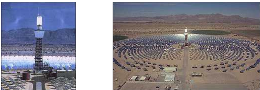
Figura 2.9 – Usina solar térmica Solar Two, localizada no deserto Mojave, na Califórnia, com capacidade de produção de 10 MW.
