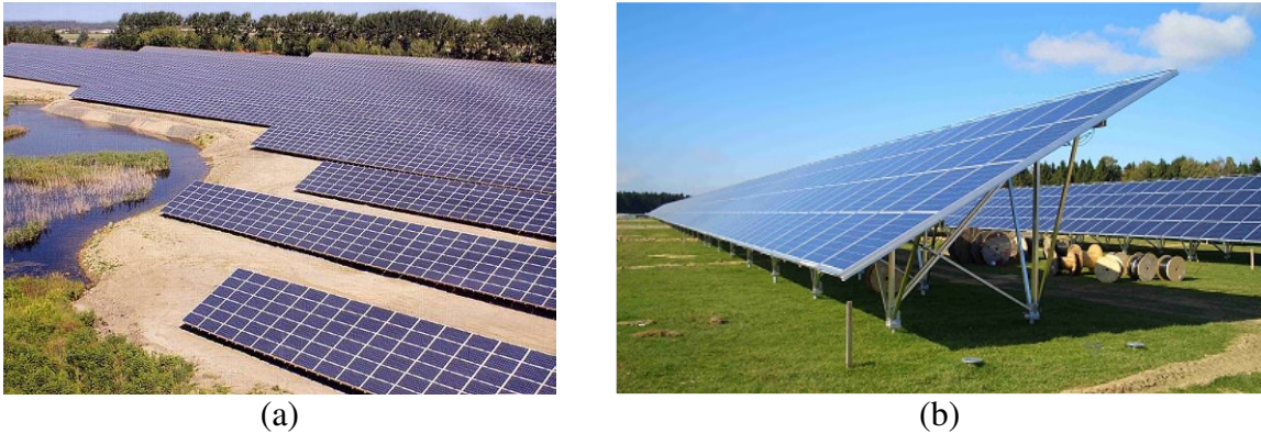
(a) (b) Figura 2.10 – Geração centralizada de energia solar fotovoltaica na Alemanha: (a) Em Leipzig, com potência instalada de 5MWpico; e (b) na Bavária, em construção, com potência projetada para 10MWpico. (fonte: Shell Solar, 2005)
