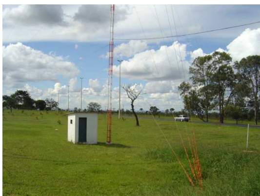
Figura 12: torre com estaios
