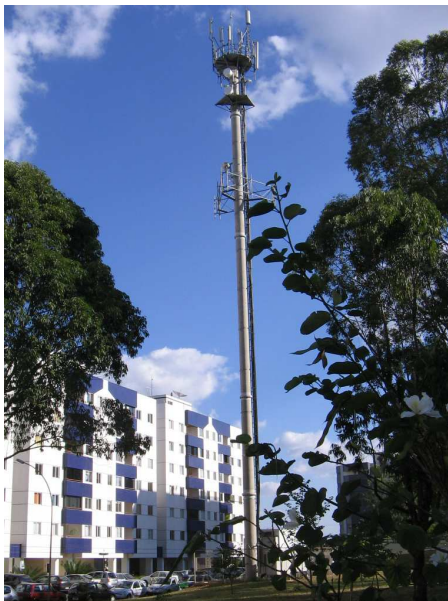
Figura 24: torre e edifício no Setor Sudoeste
