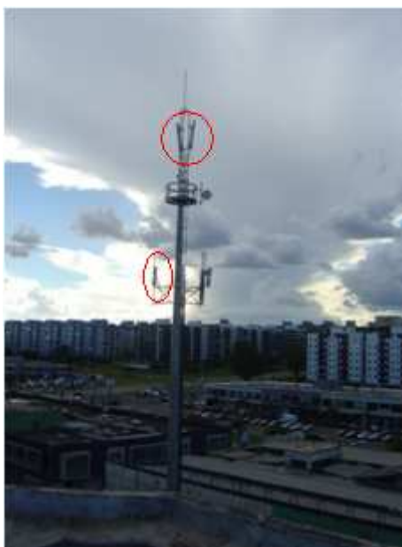
Figura 22: antenas de radiocomunicação
