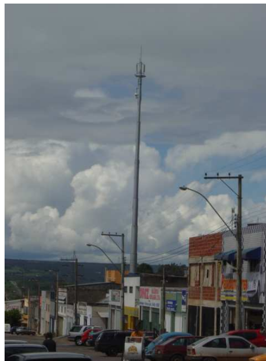
Figura 9: torre de metal
