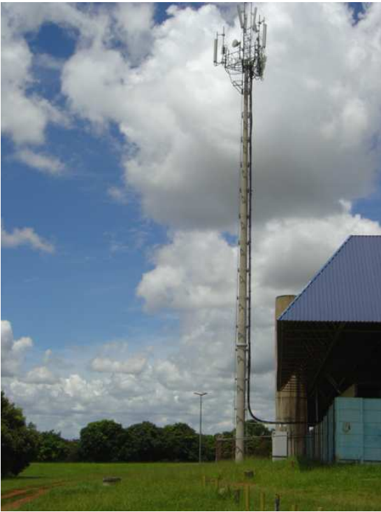
Figura 13: torre de concreto
