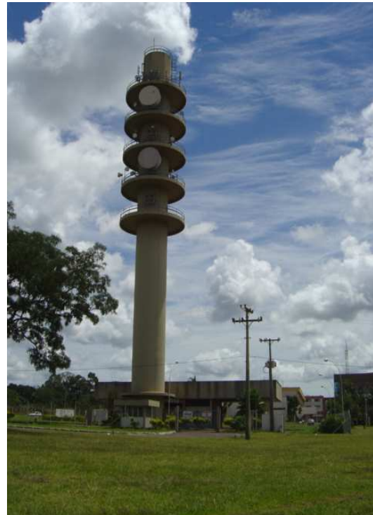
Figura 14: torre de concreto
