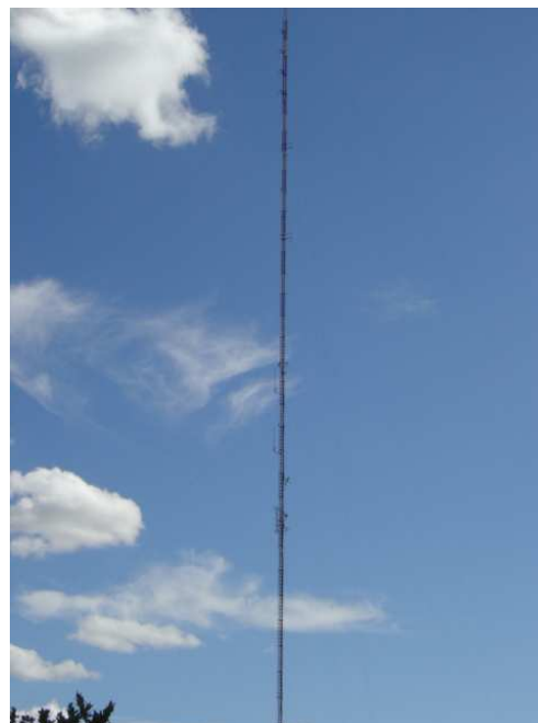
Figura 11: torres com estaios
