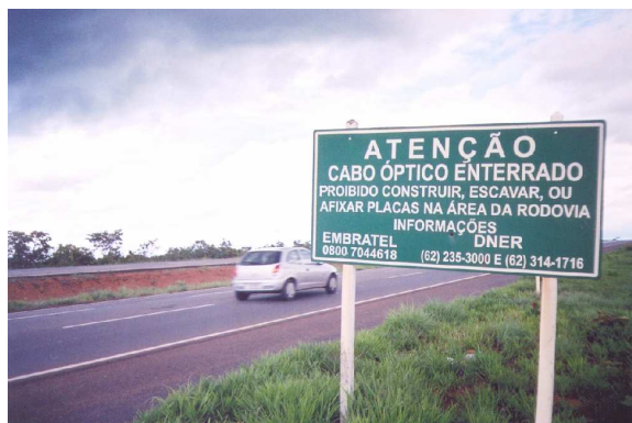
Figura 2: Cabos de fibra óptica
