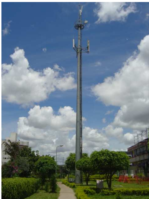
Figura 8: torre de metal
