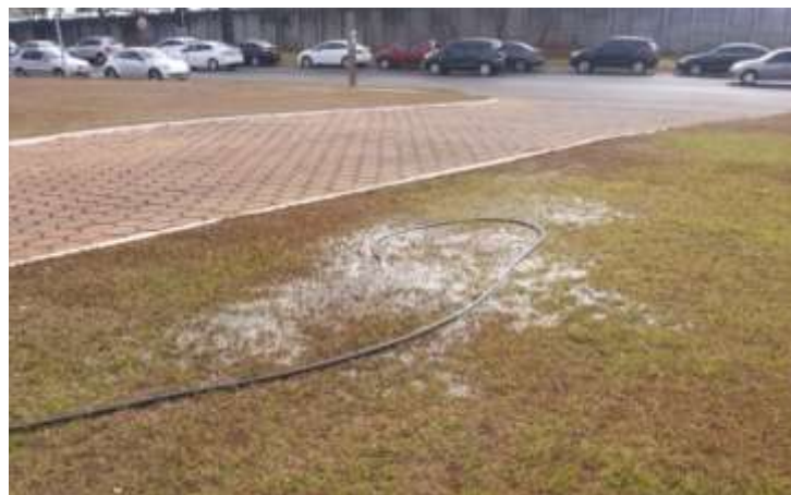
Foto 13 – Exemplo de desperdício de água no TCU em Brasília/DF
