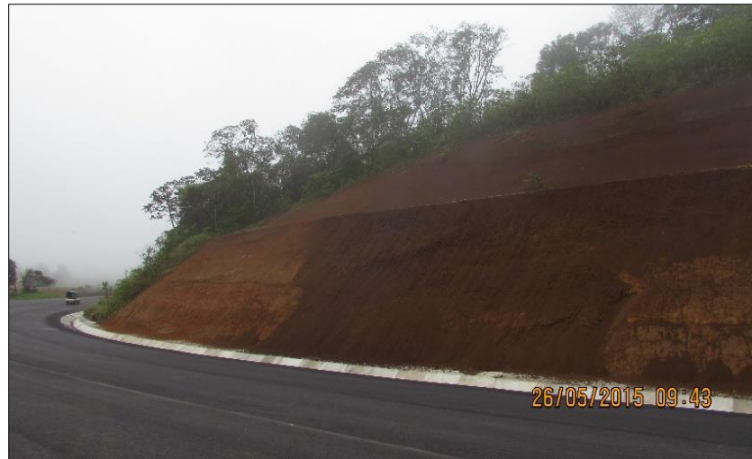
Figura 3.21. Caso de talude estável, estaca 10+180
