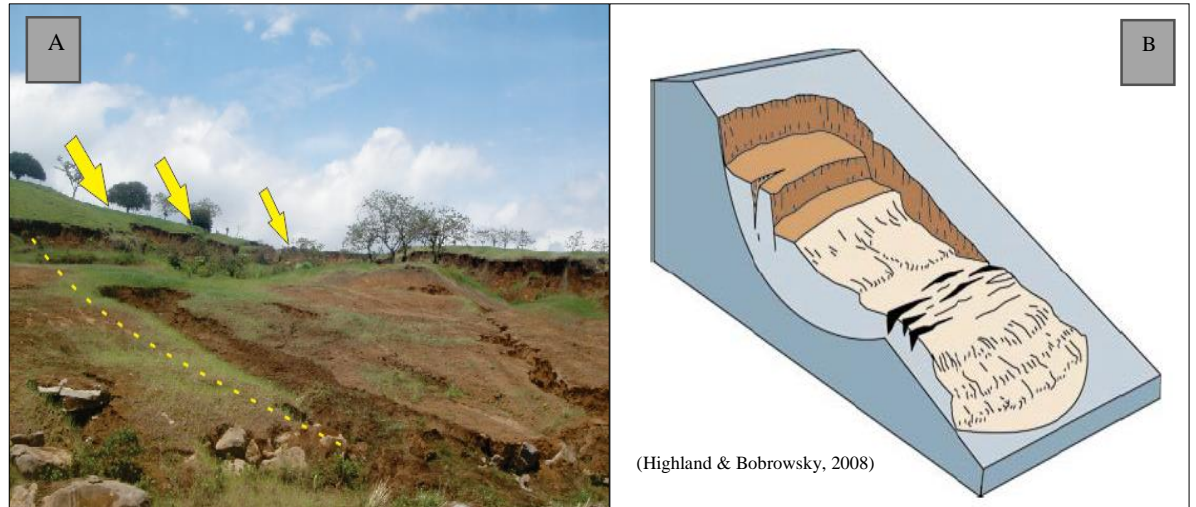
Figura 3.19. Tipo de deslizamento rotacional.
