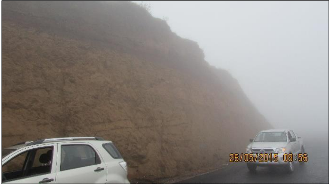
Figura 3.18. Talude estável sem proteção na face, estaca11+900.
