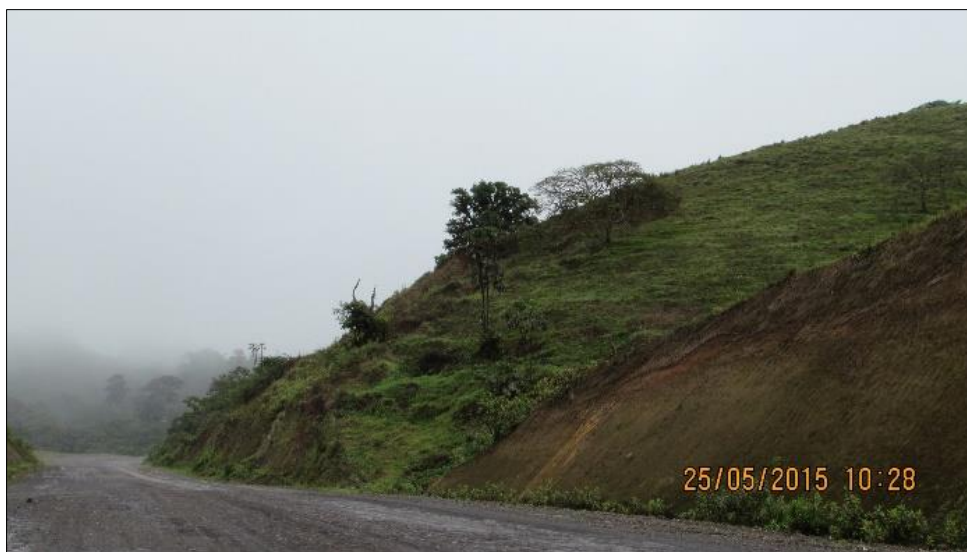
Figura 3.3. Evidência de relevo Íngreme. Encosta na estaca 15+200
