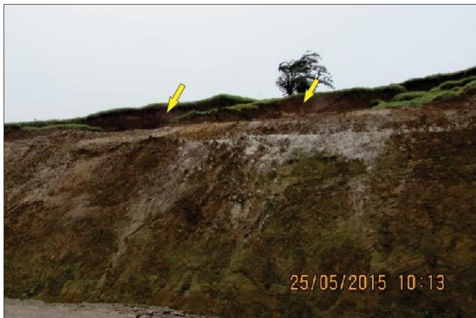
Figura 3.20. Exemplo de mecanismo de ruptura, estaca 13+000
