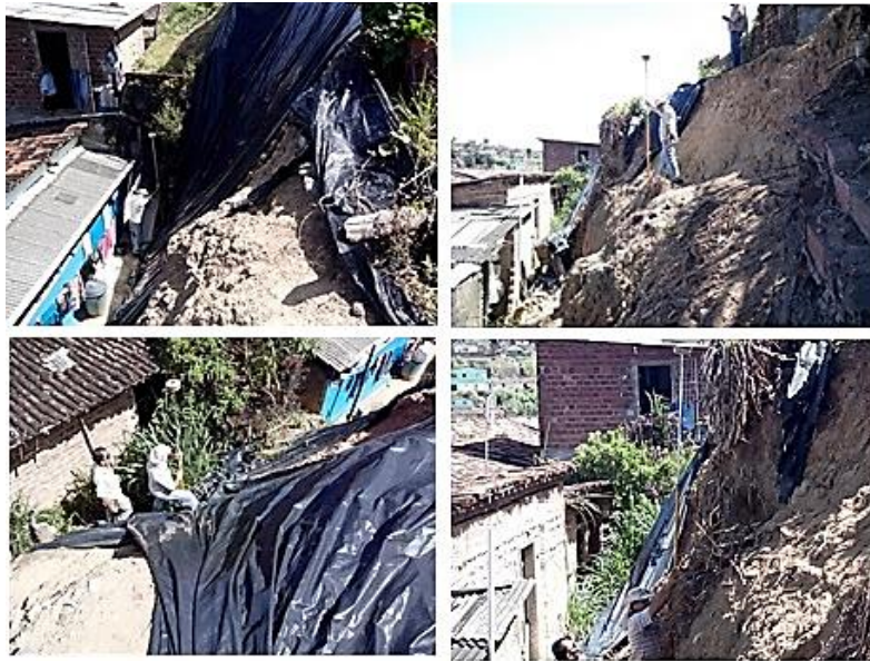
Figura 6.40: Aspectos da estrutura e encosta, objetos do levantamento RTK-NTRIP, na localidade da 3ª travessa Damolândia – Nova Descoberta – Córrego da Areia Recife, em 02/10/2013. (Foto: A autora).
