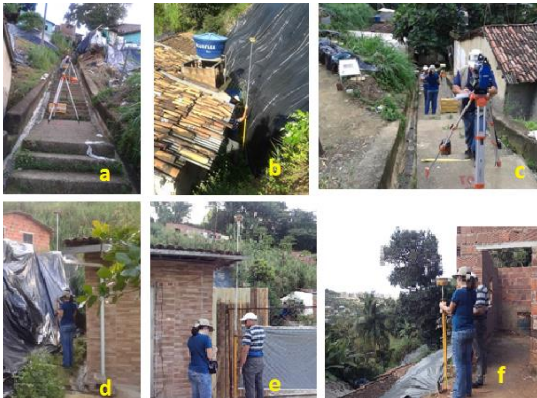
Figura 6.48: Aspectos do levantamento GNSS, RTK-NTRIP e Topográfico, na Subida para o Alto do Reservatório - Córrego do Joaquim - Nova Descoberta. Levantamento com estação total ('a' e 'c') e levantamento GNSS de estruturas (e) e de ameaças ('b', 'd' e 'f'). (Foto: Sergio Melo).
