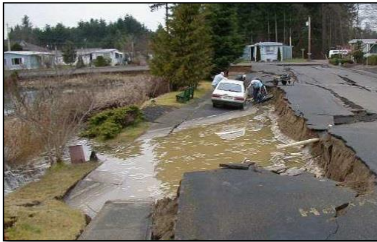
Figura 2.13: Exemplo de expansão lateral ocorrida em Sunset Lake, Washington - USA, desencadeado por um terremoto. (Fonte: Adaptado de USGS, 2004).
