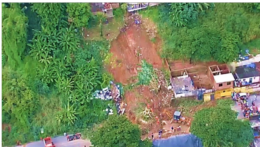
Figura 6.12: Deslizamento de barreira no Córrego do Euclides, no Alto José Bonifácio, Zona norte da cidade do Recife, com 1 vítima fatal, em 17/04/2016. (Fonte: Reprodução vídeo reportagem TV Globo, 2016).
