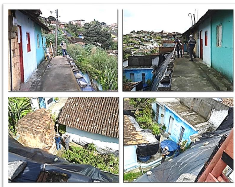
Figura 6.45: Aspectos do levantamento com Estação Total e RTK-NTRIP, na Rua Bemposta, Alto do Eucalipto – Vasco da Gama, em 18 de julho de 2014 (Foto: Sergio Melo - IBGE).
