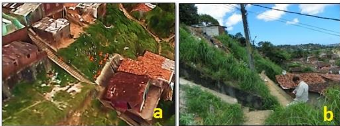
Figura 6.36: Pontos do levantamento RTK-NTRIP (a), aspecto de encosta em processo de deslizamento (b), na localidade da 2ª Travessa Doradinha – Córrego do Eucalipto - Vasco da Gama – Recife, em 02/10/2013 (Imagem tridimensional Google Earth, 2016).
