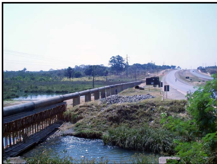
Figura 11. Fotografia da obra de porte médio, realizada durante o período de monitoramento do presente estudo, para construção de adutora da CAESB junto ao Córrego do Fumal, na rodovia BR-020.
