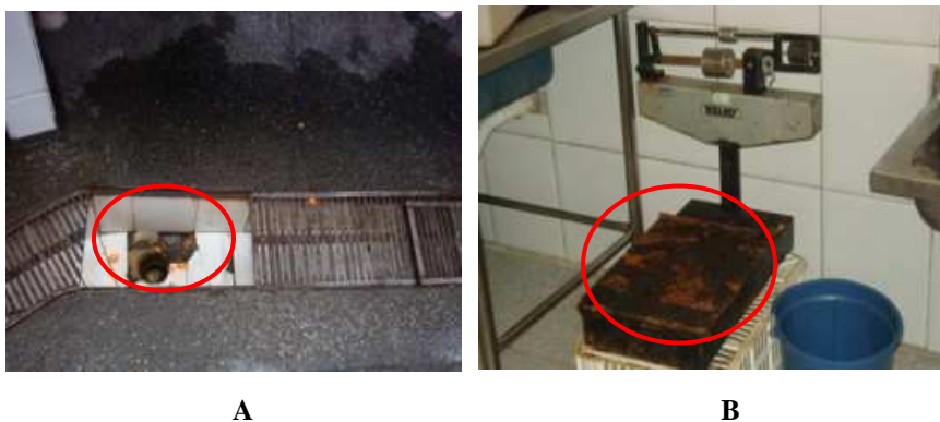
Figura 5 – Inadequações identificadas para o Bloco B - Avaliação da higienização de instalações, equipamentos, móveis e utensílios. A- Ralos sem grelhas ou ralos sifonados; B- Equipamentos sem manutenção.
