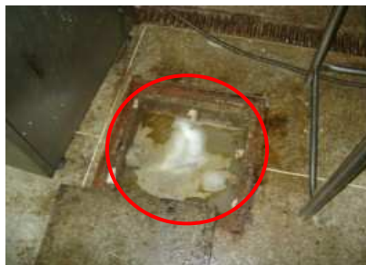
Figura 11 – Inadequação identificada no Bloco F - Avaliação do abastecimento de água e esgotamento. A - Caixa de gordura na área de produção.
