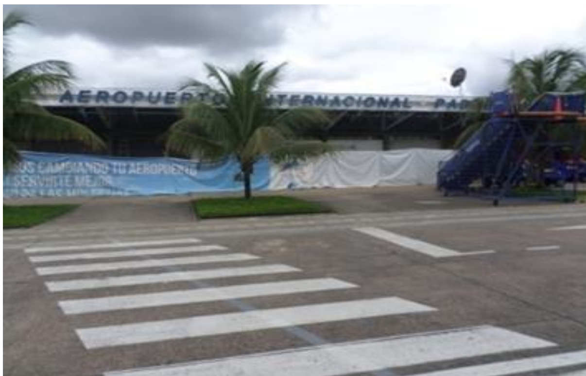
Fotografia 3 – Reforma no Aeroporto Internacional Padre Aldamiz Puerto Maldonado, Peru.
