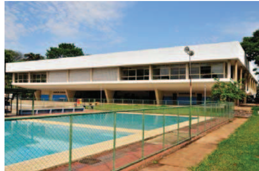
Figura 4: Bloco Principal e piscinas – Fachadas Sudeste e Nordeste.
