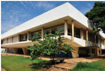
Figura 1: Bloco Principal – Fachadas Sudeste e Nordeste.
