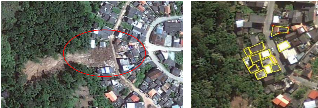
Figura 4.7 – Identificação dos elementos – deslizamentos e estruturas afetadas – para análise.
