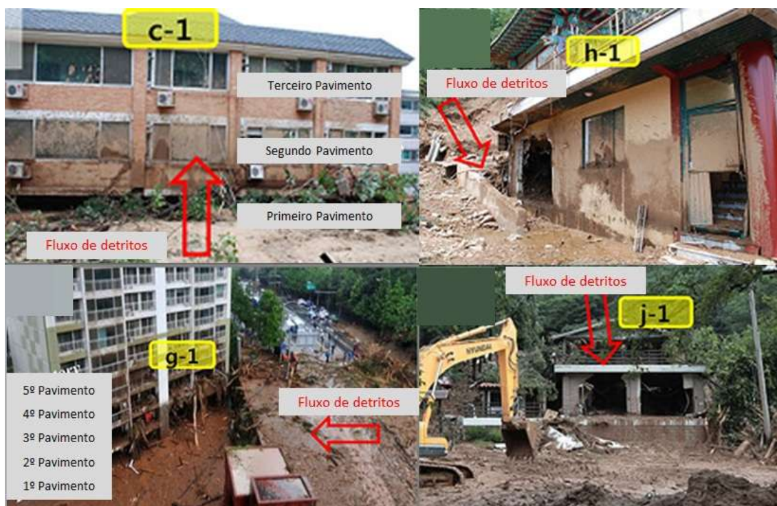
Figura 2.5 – levantamento dos danos sofridos pelas estruturas (Kang et al. 2015, Modificado).
