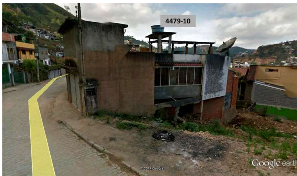
Figura 4.9 – Análise dos parâmetros de resistência das estruturas afetadas pelo deslizamento 4479 por meio da Google Street View.
