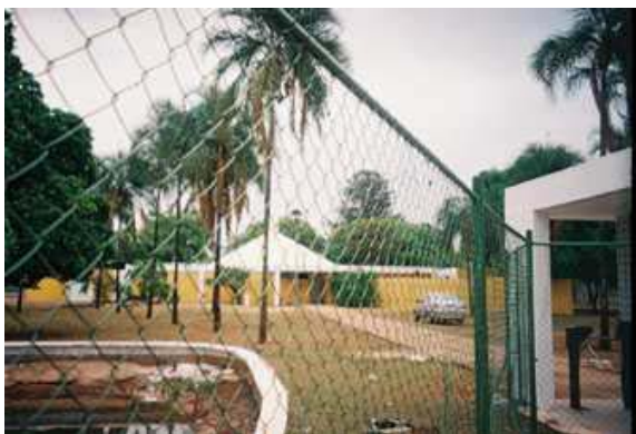
Figura 167. A área da edificação do Pesque-Parque (onde seria o restaurante no projeto) cercada. Fonte: fotografia da autora.
