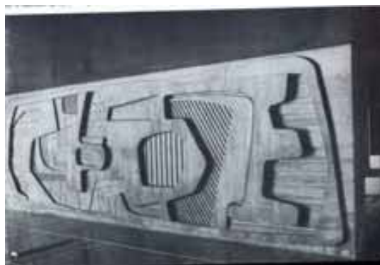
Figura 29. Painel em concreto do Centro Cívico de Santo André. Fonte: Motta, 1983.
