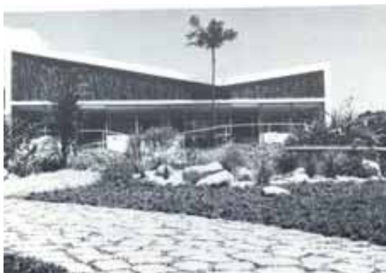
Figura 22. Residência de Juscelino Kubitschek. Fonte: Motta, 1984.
