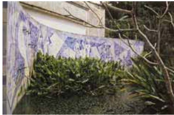
Figura 44. PAINEL cerâmico do Instituto Moreira Salles. Fonte: Siqueira, 2002.
