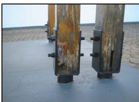
Figura 49 – Pilares da passarela (distanciados do piso)
