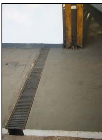
Figura 44 – Pilar do lado esquerdo da entrada principal
