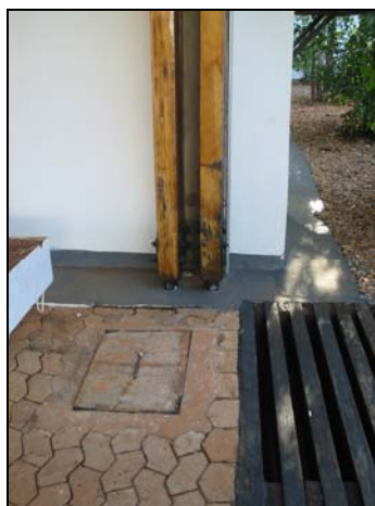
Figura 43 – Pilar do lado direito da entrada principal
