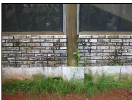
Figura 55 – Pilar protegido da umidade
