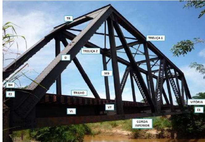
Figura 5.1- Vista geral da Ponte Suaçuí (Melo 2011).
