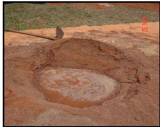
Figura 4.4. Umedecimento do solo após mistura.
