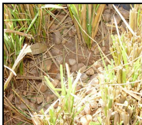
Figura 5.42. Camada superficial do wetland construído - sistema 1 (4cm/d).
