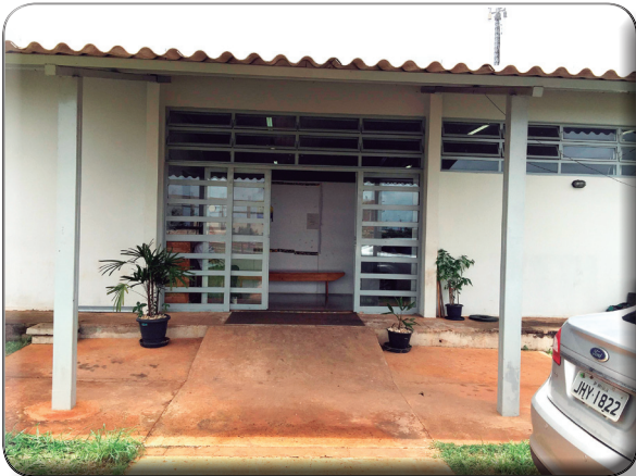
Foto nº 14: Unidade de Atendimento em Meio Aberto - UAMA, no Recanto das Emas
