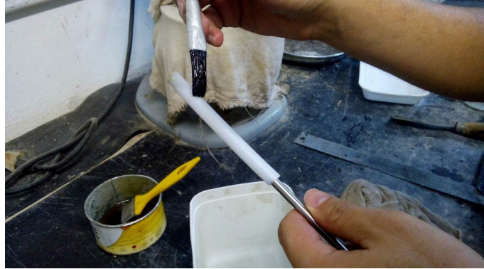
Figura 3.25 – Óleo mineral sendo aplicado na mangueira para evitar aderência com o concreto.
