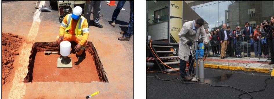
Figura 2.19. Métodos destrutivos para avaliação estrutural de pavimentos. a) Frasco de areia após abertura de trincheira. Fonte: Dynatest. b) Extração de corpo de prova em estrutura de pavimento com sonda rotativa Fonte TCE-SC.
