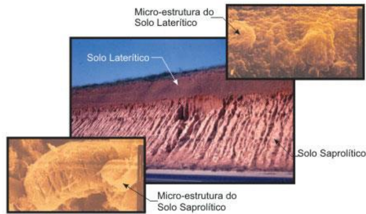
Figura 2.6. Corte rodoviário, com camada laterítica sobrejacente a uma camada saprolítica de origem sedimentar, com as correspondentes micro-fábricas (Villibor et al. , 2009).
