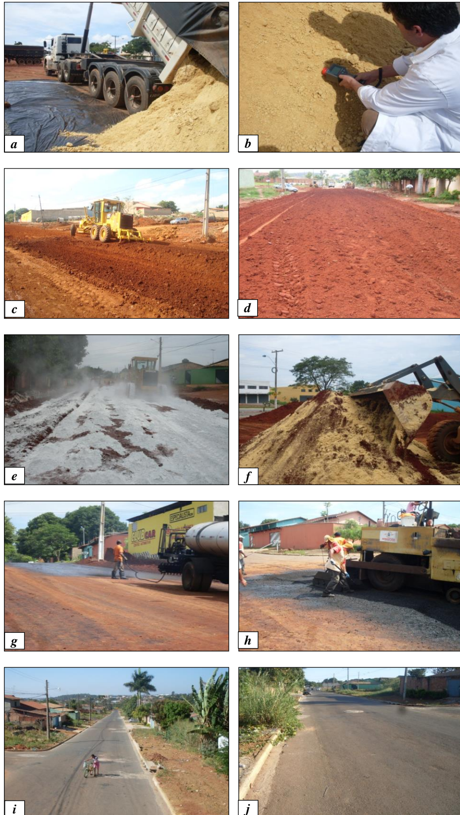
Figura 2.5 – Etapas da construção da pista experimental. (a) Fornecimento do fosfogesso em campo. (b) Medições radiométricas. (c) Preparo do subleito. (d) Preparo da camada de base. (e) Mistura com cal. (f) Mistura do solo com fosfogesso. (g) Imprimação das camadas de base. (h) Aplicação do pré-misturado a frio. (i) e (j) Aspectos finais da pista experimental. (Metogo, 2010).
