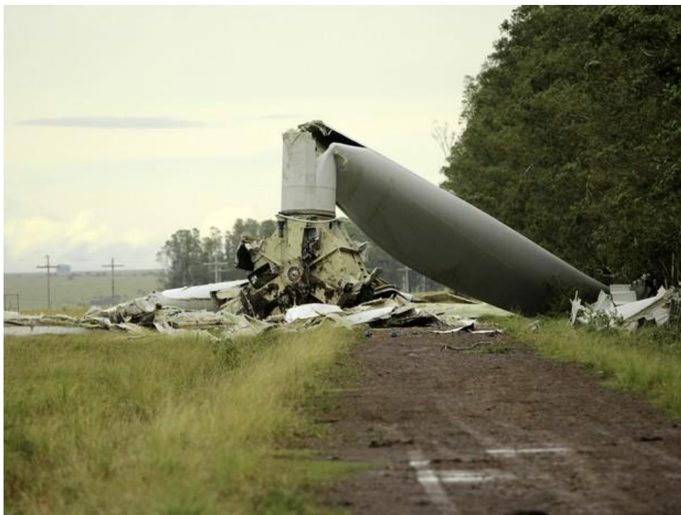
Figura 1.1 – Torre eólica caída no Complexo do Chato (Foto: Ribeiro, 2014).
