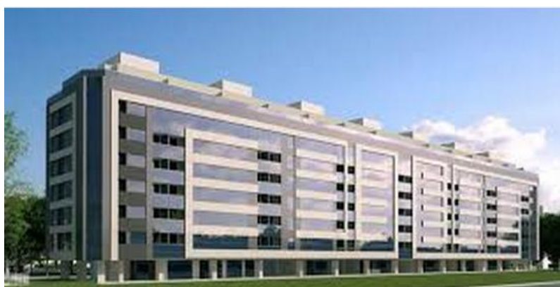
Figura 2.20 – Edifícios em construção no setor Noroeste
