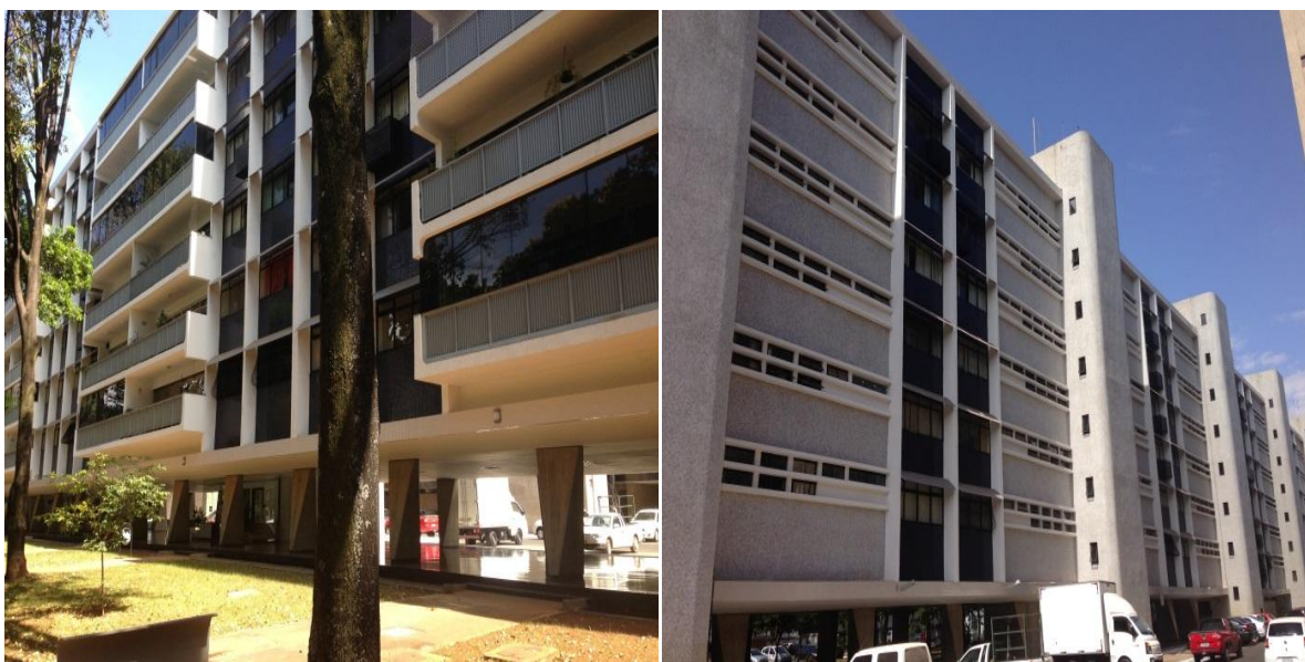
Figura 4.7 – Fachadas do edifício residencial localizado na SQS 216 CD
