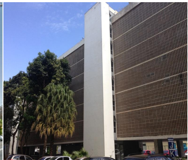
Fachada Oeste - Posterior
