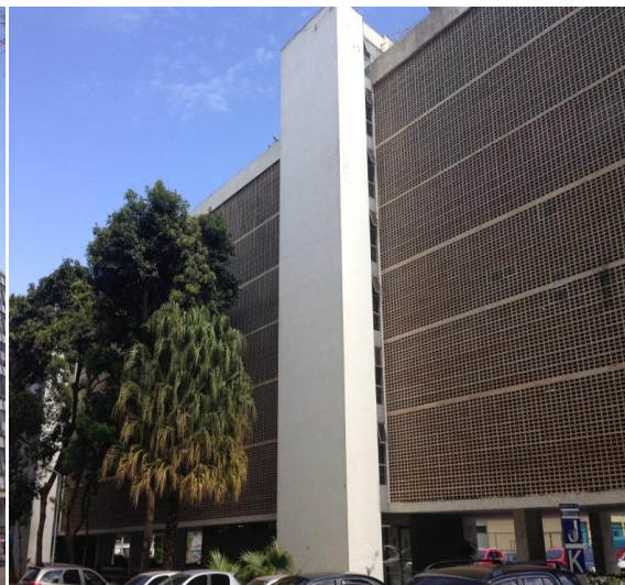
Fachada Oeste – Posterior
