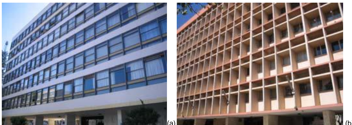
Figura 2.17 – Edifícios construídos de 1960 a 1980, (a) SQS 106 Bloco B e (b) SQS 111 Bloco J
