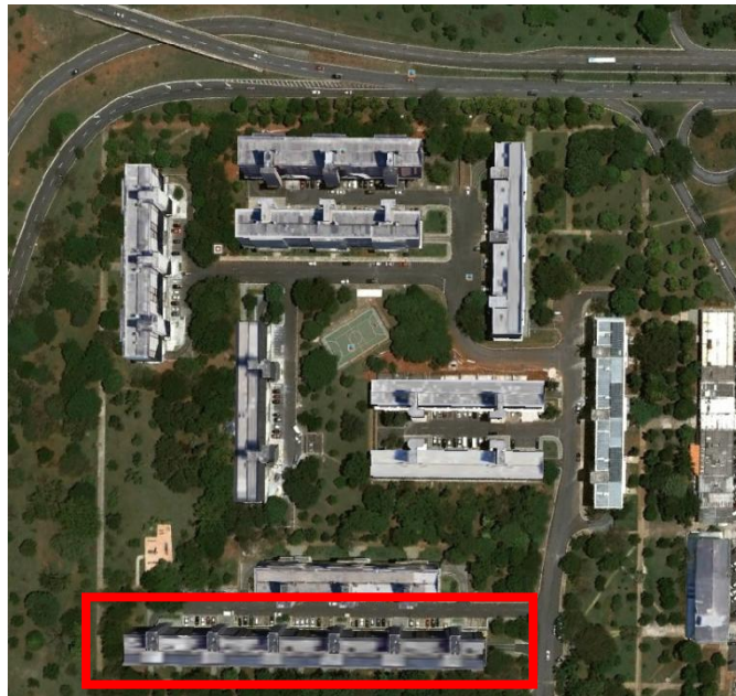
Vista aérea da localização
