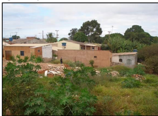
Figura 10: Construções e desmatamento nas margens do Córrego Grotão.
