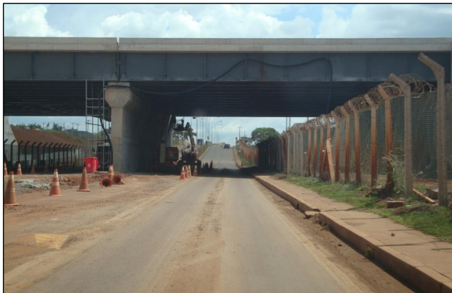
Figura 14 - Construção de nova taxiway para acesso da segunda pista ao terminal de passageiros.
