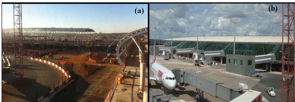
Figura 12 – (a) Construção do Píer Sul. (b) Píer Sul próximo da inauguração.
