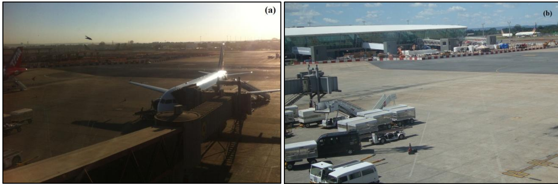
Figura 13 – (a) Início das Obras do Píer Norte. (b) Obra mais adiantada no Píer Norte.
