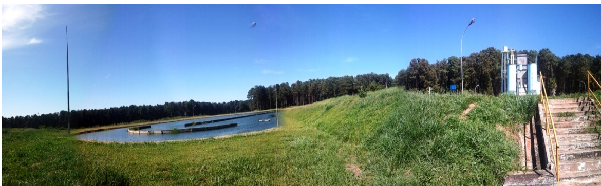
Figura 4.5 - Vista panorâmica da instalação piloto + lagoa de alta taxa afluente utilizada no estudo.
