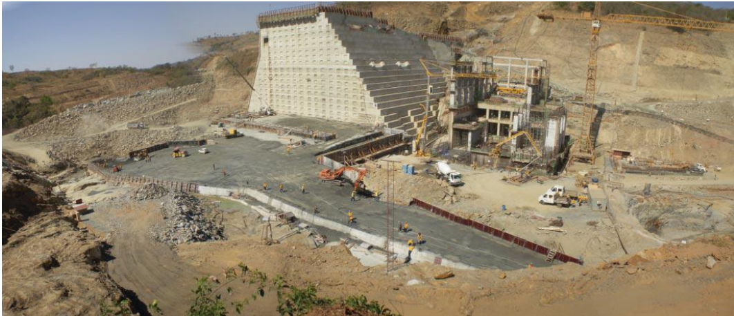
Figura 3-2 – Bloco de concretagem – MAIN BRAZILIAN DAMS (2000).
