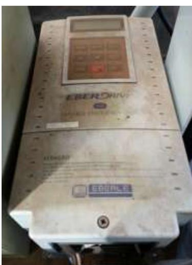
Figura A.8 – Inversor de frequência.
