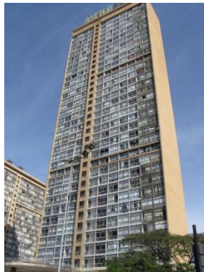
(a) Edifício JK – Belo Horizonte/MG (1952)
