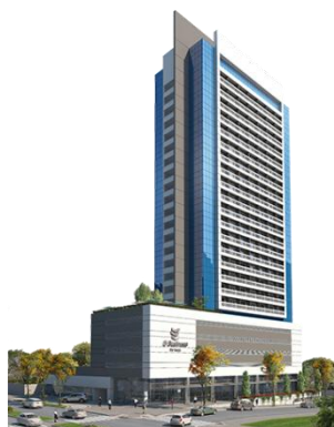
(a) Vista Fachada
