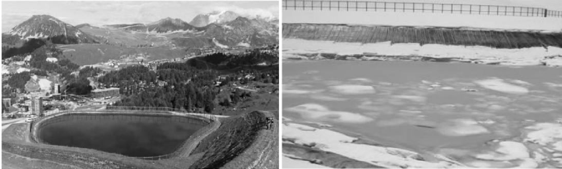
Figura 2.1. Esq.: Reservatório de montanha na França. Dir.: Derrapagem de gelo sobre a geomembrana num reservatório de montanha (Girard *et al.*, 2010).
