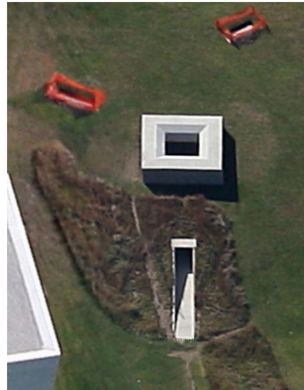
Figura 40: Vista aérea do Sky Peshar evidenciando redução de espessura no teto da instalação. Fonte: Google Earth
