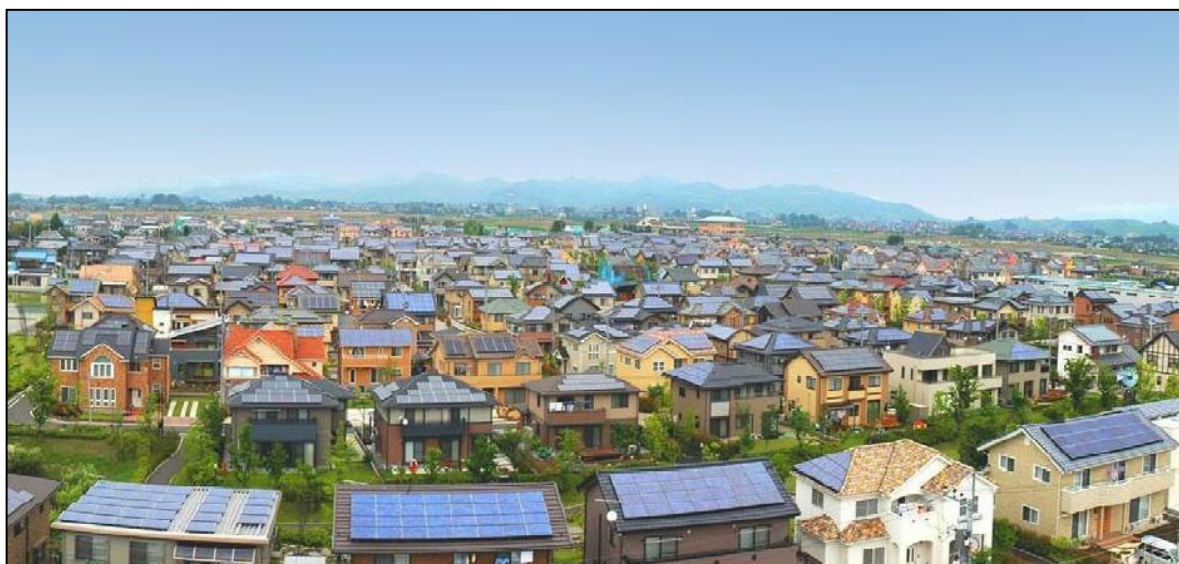
Figura 2.12 – Painéis fotovoltaicos instalados na cidade de Ota, no Japão.
