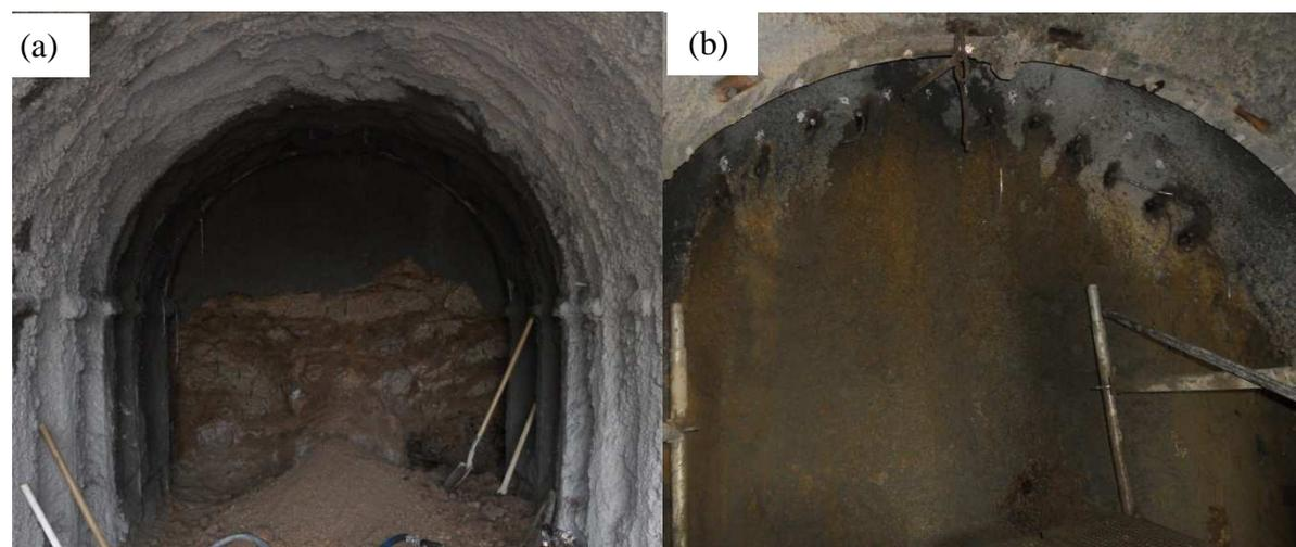
Figura 3.10 Ilustração do processo construtivo das enfilagens em um portal de um túnel. (a) Continuação da escavação do túnel com instalação da cambota metálica e concreto projetado. (b) Antes de chegar ao final da primeira enfilagens, se inicia com a construção das seguintes enfilagens.
