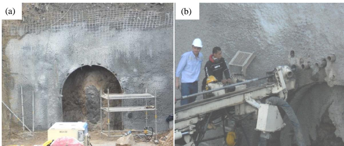
Figura 3.8 Ilustração do processo construtivo das enfilagens em um portal de um túnel. (a) Observa-se um panorama da proteção do portal do túnel e instalação da primeira cambota de apoio (b) Perfuração e instalação do tubo de aço e injeção da calda de cimento.
