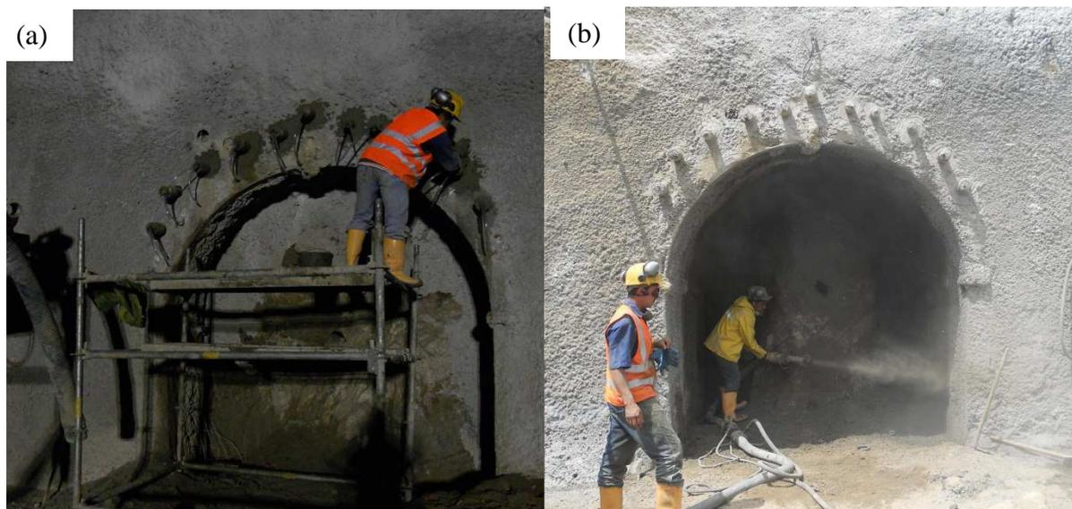
Figura 3.9 Ilustração do processo construtivo das enfilagens em um portal de um túnel. (a) Injeção da calda de cimento. (b) Aplicação do concreto projetado como um sistema de suporte no contorno do túnel entre as cambotas.
