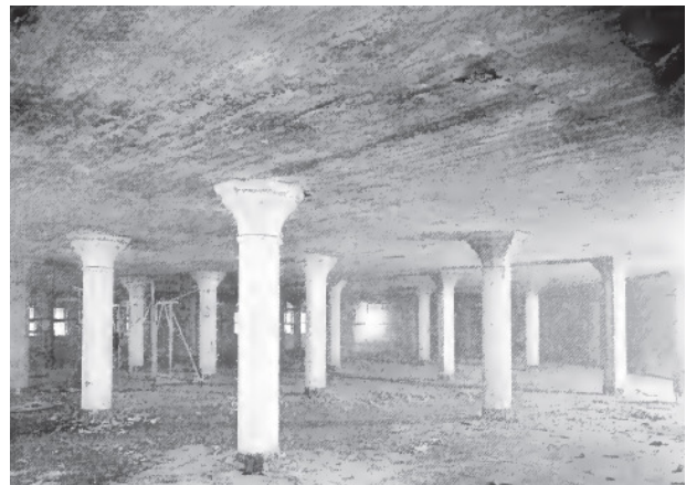
b) Interior do prédio Johnson-Bovey (1906)
