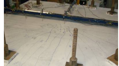
b.3) Nível de carga: 0.79 \cdot P_u (primeiras fissuras radiais)
