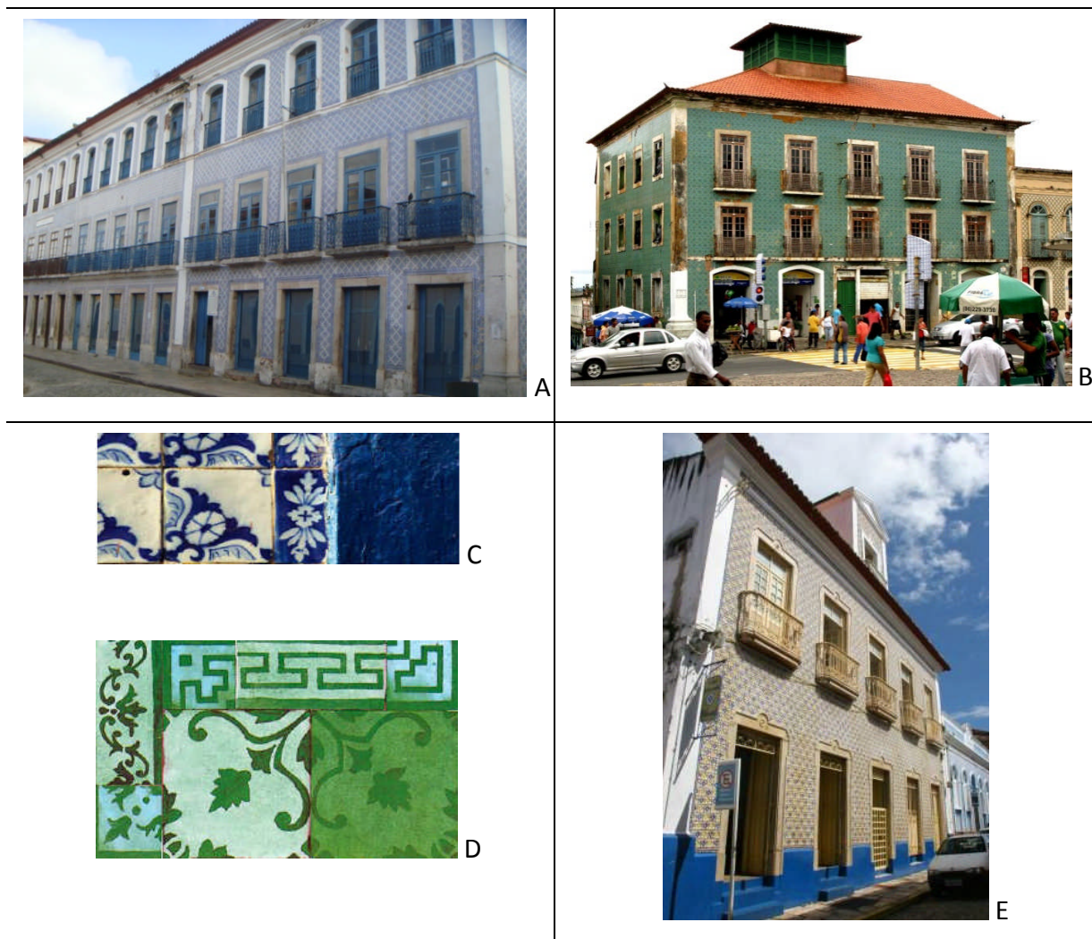
Figura 96: Composição dos revestimentos exteriores. (A) Sobrados da Rua Portugal, (o autor), (B) Sobrado no largo do Carmo nº 37, (o autor), (C e D) pormenores dos azulejos (o autor), (E) Sobrado da Rua Afonso Pena nº 112.
