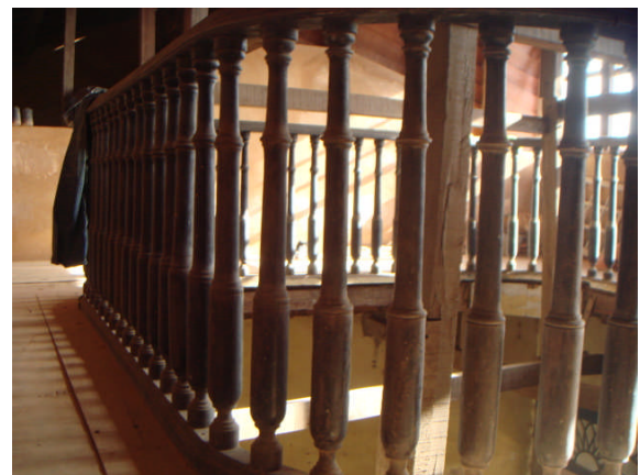
Figura 42: escadas com balaústres metálicos e corrimãos de madeira (A) Rua da Estrela nº321, (B) Rua Afonso Pena nº112. (C) e (D) Pormenor dos balaústres em madeira com torneados finos. Rua Afonso Pena nº 46. (o autor).
