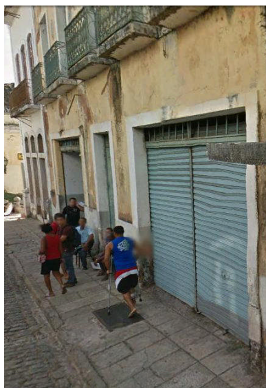
Figura 112: Alteração Estrutural. Aberturas de vãos na fachada / pavimento térreo, (A) Sobrado na Rua da Palma nº 58, (o autor). (B) Sobrado nº 195 Rua da Palma, (o autor).
