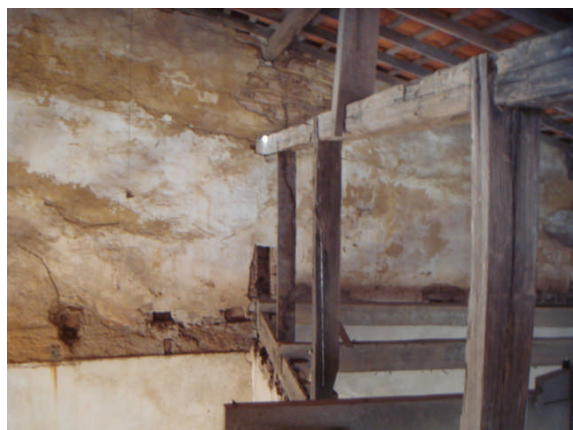
Figura 60: Pormenor dos pontaletes de sustentação da cumeeira. Solar da Rua Afonso Pena nº 46. (o autor).
