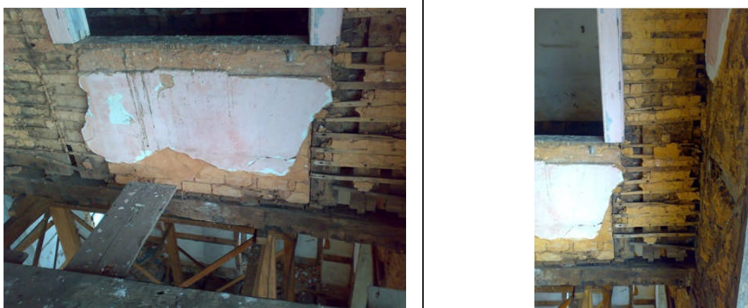
Figura 30: parede em pau-a-pique Solar nº 46 Rua Afonso Pena. (3ª SR/IPHAN-2010).
