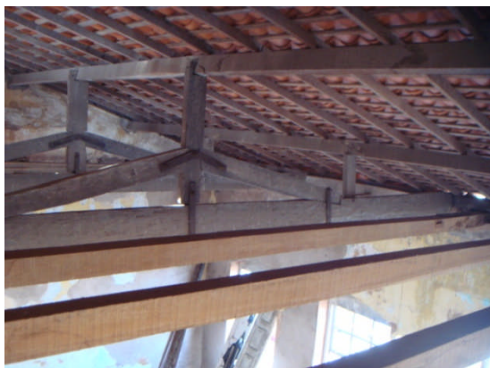
Figura 59: Variações de tesouras. (A) Tesoura comum com ferragens, Solar da Rua Afonso Pena nº 46, (o autor). (B) Tesoura de linha reta ou “canga de porco” de linha alta e baixa, Rua do Egito nº 106, “Solar dos Veras”, (o autor).
