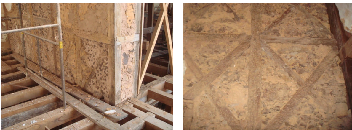
Figura 29: Parede em Cruz de André com enchimento de barro. Solar nº 46 Rua Afonso Pena. (o autor).
