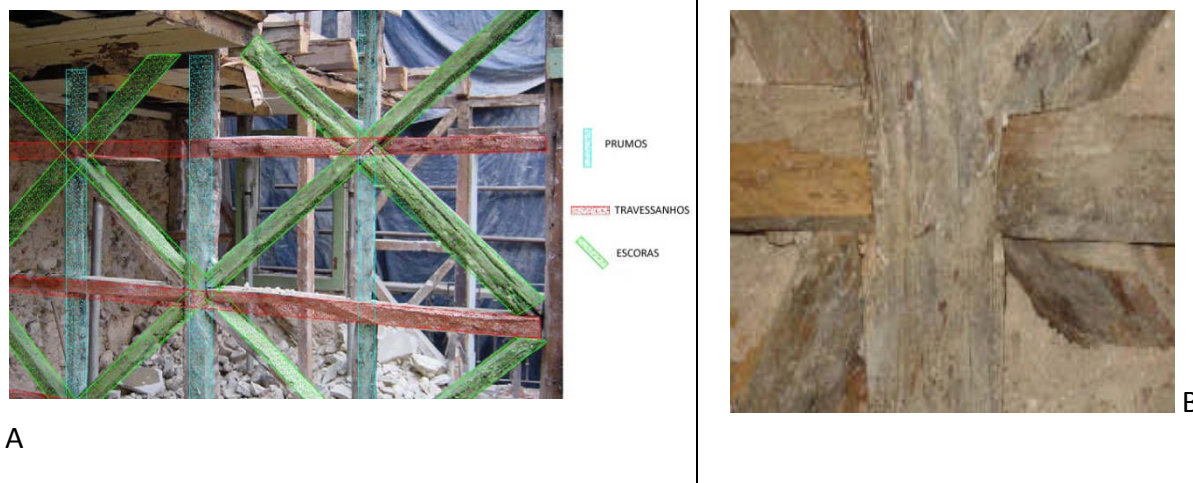
Figura 17: (A), Disposição dos elementos estruturais da "gaiola". (B) Detalhe de encaixe macho e fêmea da cruz de Santo André. (Adaptado de MIRANDA, 2011).
