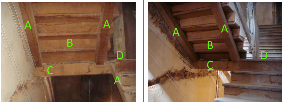
Figura 44: Pormenor da estrutura da escada Rua da Estrela nº 82 esquina com Rua de Nazaré. A-perna, B-espelho, C-barrote, D-piso. (o autor)
