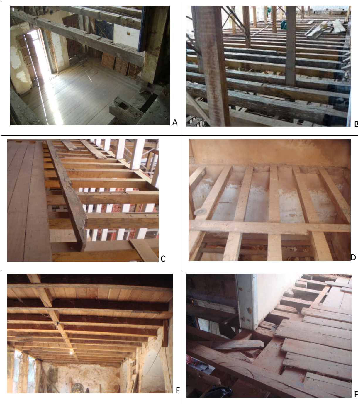
Figura 72: (A e B) Vista geral do pavimento de um piso com disposição das vigas (barrotes) de sustentação, (3ª SR/IPHAN-2008). (C e D) Pormenor da disposição das vigas (barrotes) com colocação do tabuado. (o autor). (E e F) Pormenor do encaixe das vigas (barrotes) na alvenaria. (o autor).
