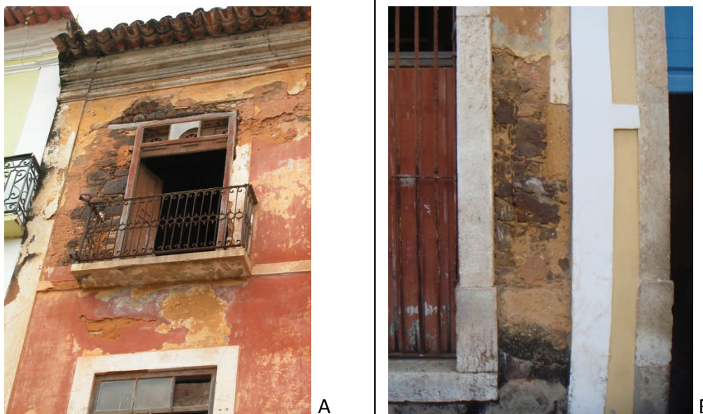
Figura 27: fachadas externas em pedra e cal rebocadas com argamassa e barro. (A) Rua do Giz nº295, (B) Rua de Nazaré nº 170 esquina com Rua da Estrela. (o autor).
