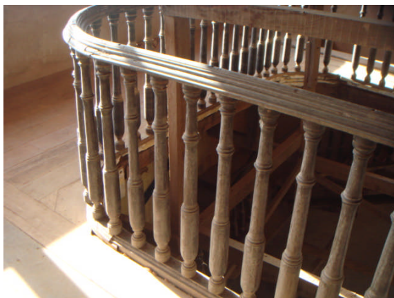
Figura 42: escadas com balaústres metálicos e corrimãos de madeira (A) Rua da Estrela nº321, (B) Rua Afonso Pena nº112. (C) e (D) Pormenor dos balaústres em madeira com torneados finos. Rua Afonso Pena nº 46. (o autor).
