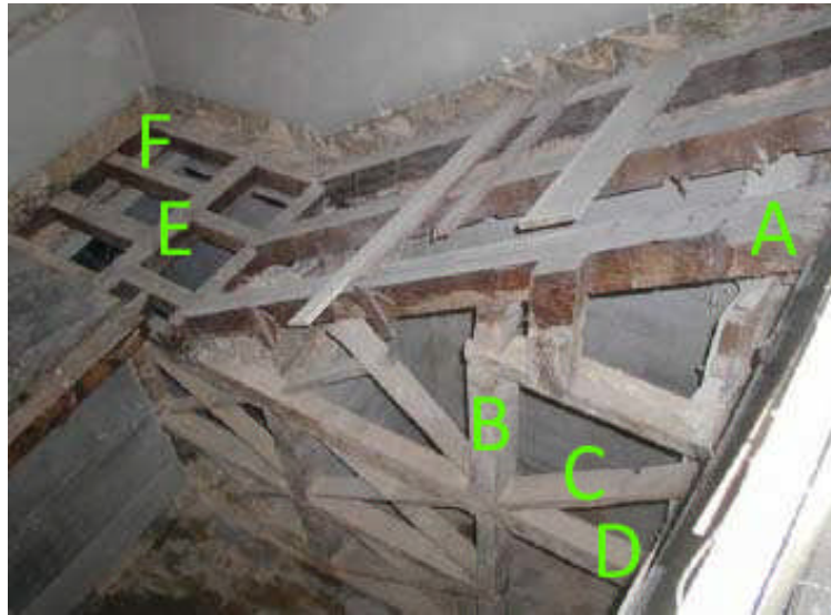
Figura 33: Estrutura de escadas em madeira: A-Perna, B-Prumo, C-Escora, D-Travessanho, E-Cadeira, F-Tarugo. (Adaptado de APPLETON, 2009, p. 47)
