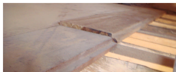
Figura 73: (A e B) Detalhe das emendas e sistema de contraventamento das vigas (barrotes), projeto de recuperação estrutural do Solar da Rua Afonso Pena nº 46 (3ª SR/IPHAN-2010). (C e D) Detalhe do sistema de juntas do tabuado (assoalho) tipo macho e fêmea. (o autor)
