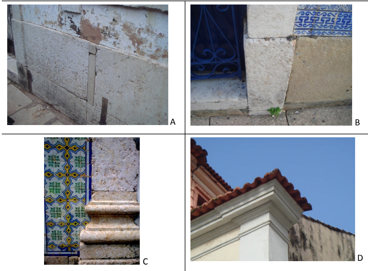
Figura 52: Pormenor de barrado liso, (A) Solar da Rua Afonso Pena nº 46. (B) Sobrado da Rua Portugal nº 285. (C) Pormenor da base de um cunhal, Sobrado da Rua Portugal nº 199, (D) Pormenor do capitel de um cunhal. Rua da Estrela nº 124, (o autor).
