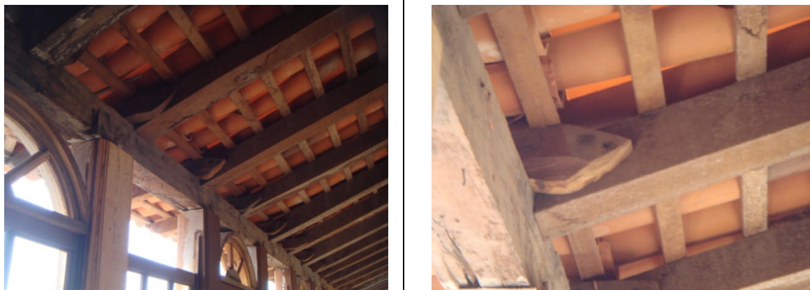
Figura 61: Pormenor dos beirais internos com os respectivos “cachorros”. Solar da Rua Afonso Pena nº 46. (o autor).
