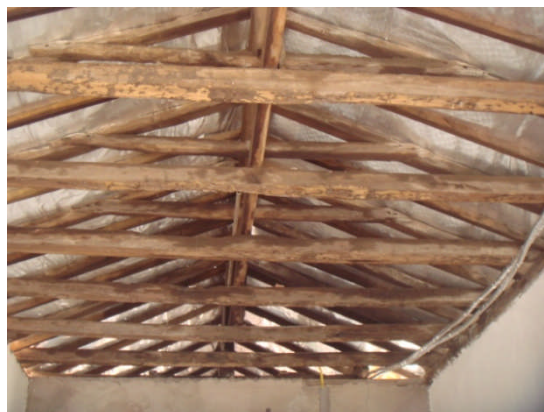
Figura 59: Variações de tesouras. (A) Tesoura comum com ferragens, Solar da Rua Afonso Pena nº 46, (o autor). (B) Tesoura de linha reta ou “canga de porco” de linha alta e baixa, Rua do Egito nº 106, “Solar dos Veras”, (o autor).
