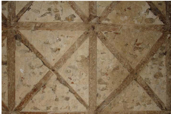
Figura 23: Frontal preenchido com argamassa de cal, pequenas pedras e elementos cerâmicos. (Adaptado de MIRANDA, 2011).
