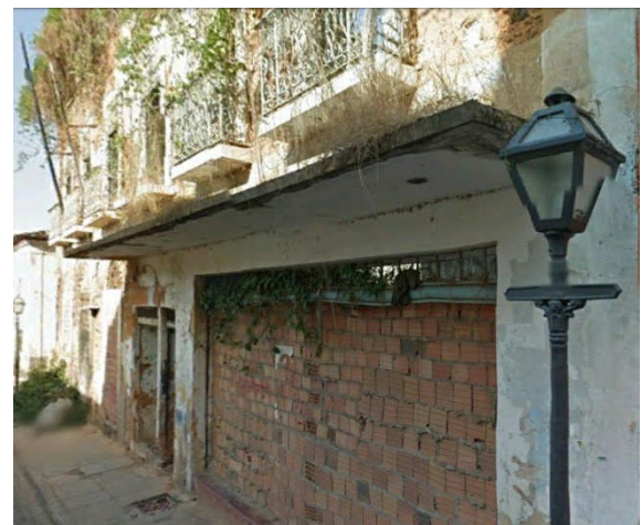
Figura 112: Alteração Estrutural. Aberturas de vãos na fachada / pavimento térreo, (A) Sobrado na Rua da Palma nº 58, (o autor). (B) Sobrado nº 195 Rua da Palma, (o autor).
