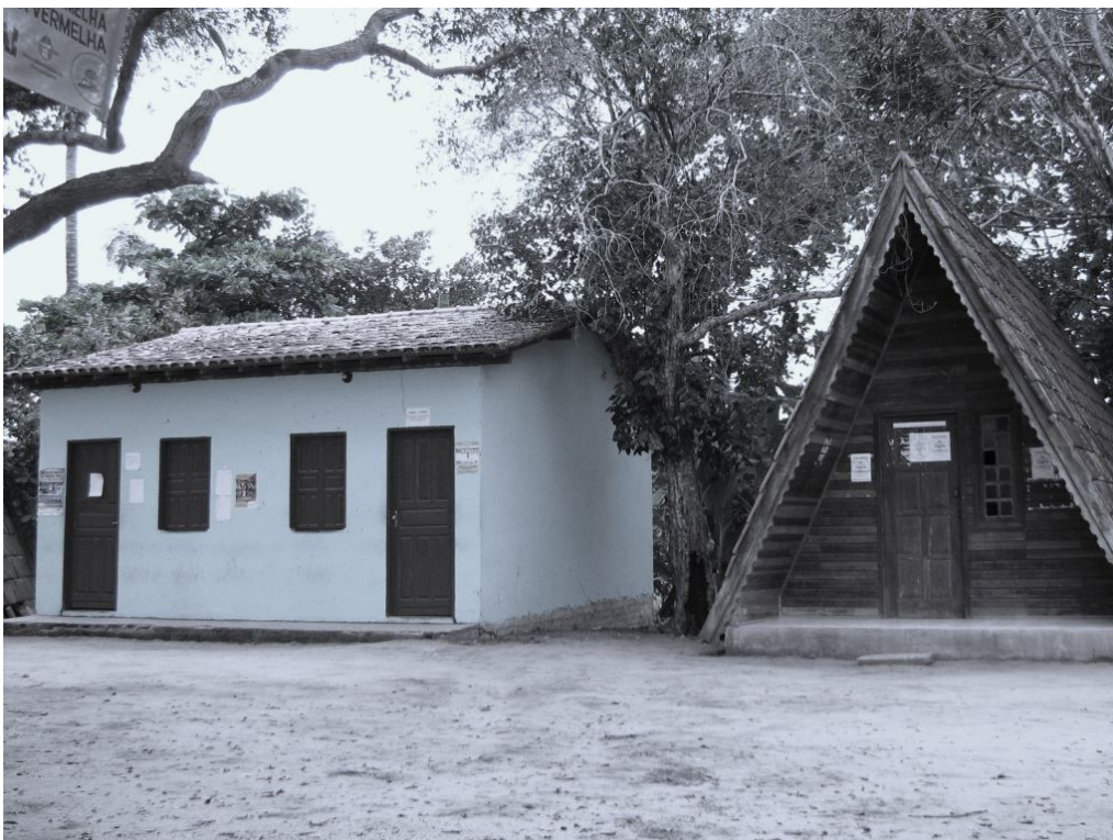
Figura 10 – Prédio do escritório do Cacique (à direita) e escritório da Guarda (à esquerda)
