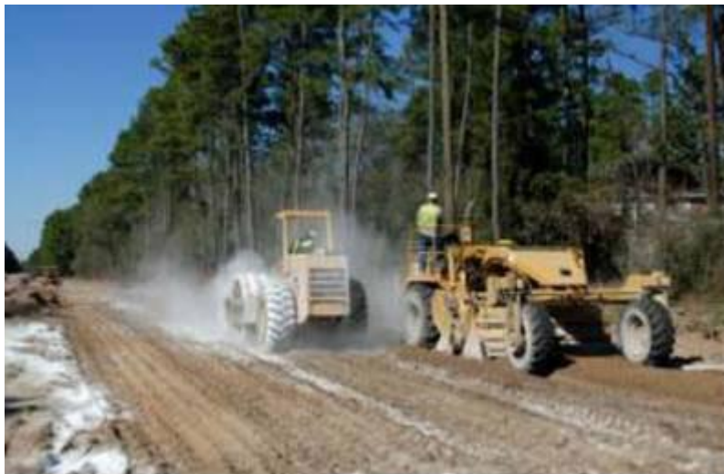
Figura 2.9 - Utilização de cal em camadas de pavimentos (Fonte: Minascal)
