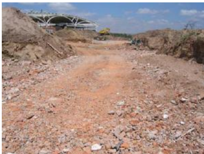
Figura 2.4 – Utilização de RCD em camadas de pavimentação (Fonte: Leite, 2007)
