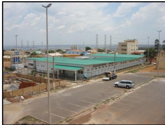
Figura 4.21 – Vista da UPA Samambaia/DF. Fonte: Autor (2012).
