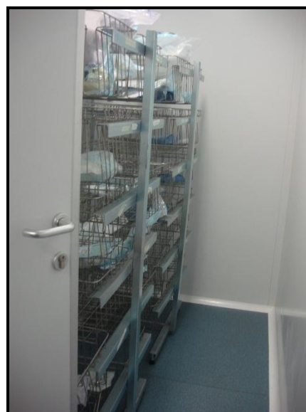
Figura 4.31 – Guarda de material esterilizado da UPA Samambaia/DF. Fonte: Autor (2012).
