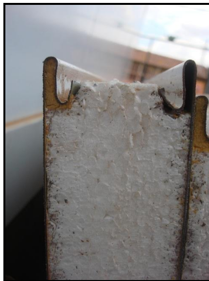
Figura 4.18 – Painéis Modulares da UPA Samambaia/DF. Fonte: Autor (2012).
