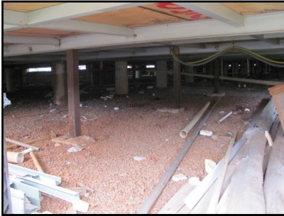
Figura 4.19 - Piso flutuante e estrutura metálica da UPA Samambaia/DF. Fonte: Autor (2012).
