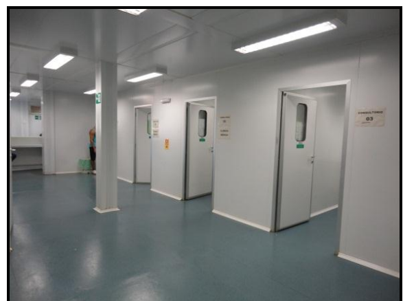
Figura 4.24 - Hall de Consultórios da UPA Samambaia/DF. Fonte: Maria José Branco (2011).
