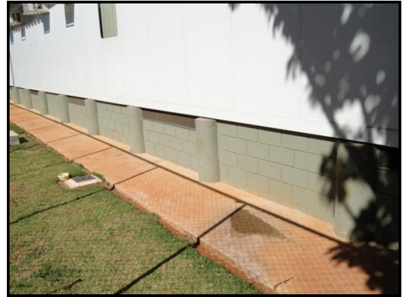
Figura 4.20 - Estrutura de apoio da UPA Samambaia/DF. Fonte: Autor (2012).
