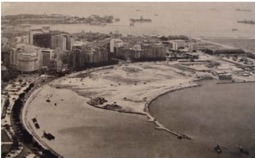
Figura 26: Começo do aterro na altura da Avenida Rio Branco, ainda no ano de 1954. À direita, vemos o aeroporto Santos Dummont. Esta região é onde, hoje, encontramos o monumento aos Mortos da II Guerra (pracinhas) e o Museu de Arte Moderna. (Referência bibliográfica: Revista Municipal de Engenharia, volume XXI, janeiro/março de 1954, número 1).
