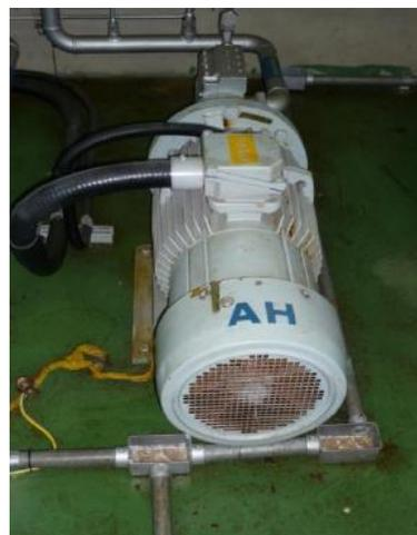
Figura B. 1- Motobombas AG - AH do sistema de resfriamento do mancal escora
