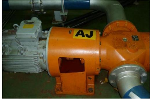
Figura B. 2 -Motobombas AJ – AI do sistema de resfriamento do mancal guia
