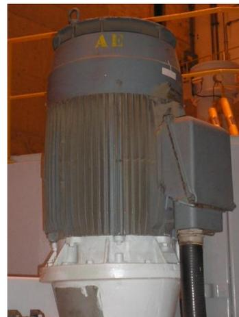
Figura B. 4 -Motobombas AE-AF do tanque sem pressão
