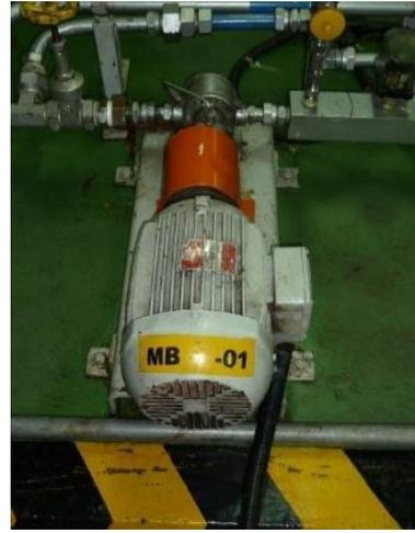
Figura B. 3 -Motobombas 01 – 02 do sistema de resfriamento do mancal guia superior
