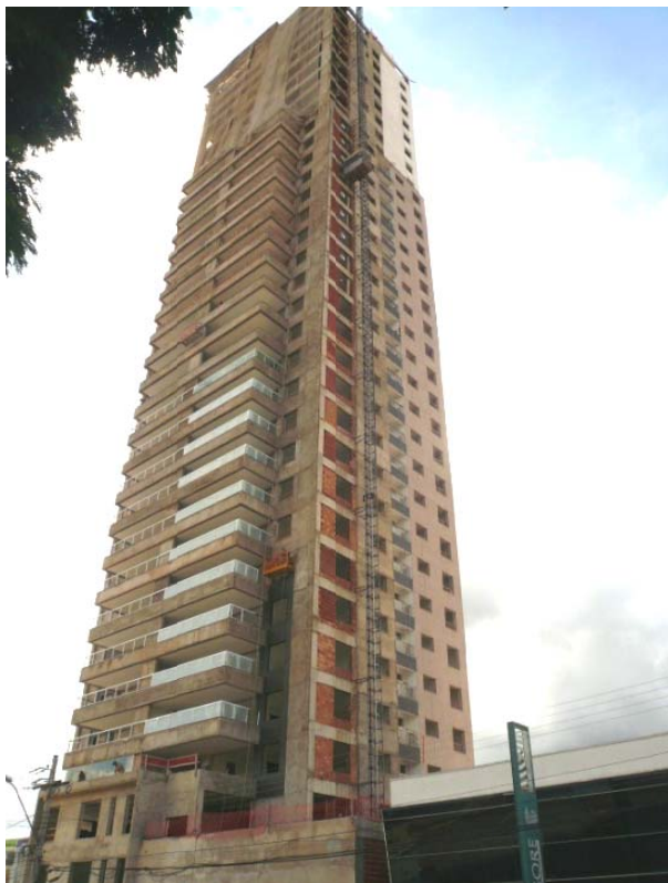
Figura 4.85. Fachada da obra no final da pesquisa
