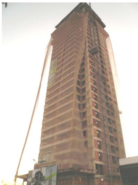
Figura 4.3. Visão da fachada do empreendimento “obra A”
