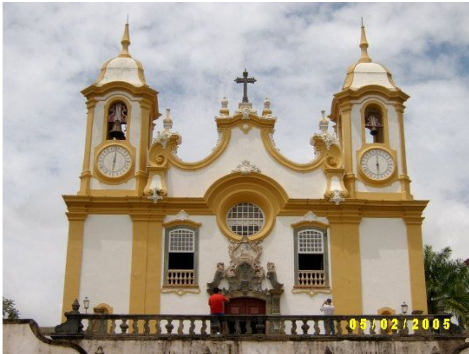
FOTO 3 - Matriz de Santo Antônio: obra-prima da arquitetura colonial barroca mineira. Pólo de atração para o Turismo Cultural, como os demais bens da cidade / Everaldo Costa, fevereiro de 2005.
