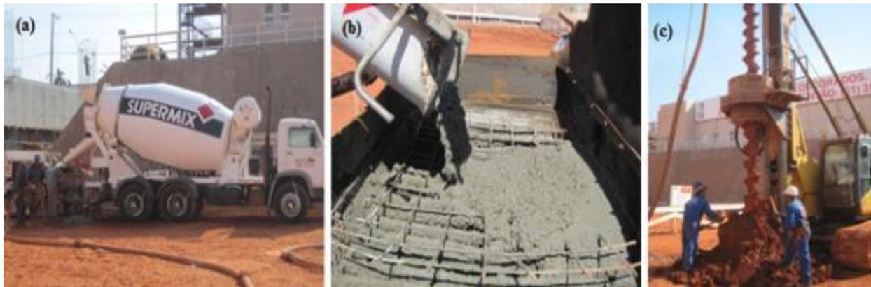
Figura 2.5 - Concretagem: (a) Preparação do caminhão betoneira (b) Lançamento do concreto no carro guia (c) Limpeza do trado
