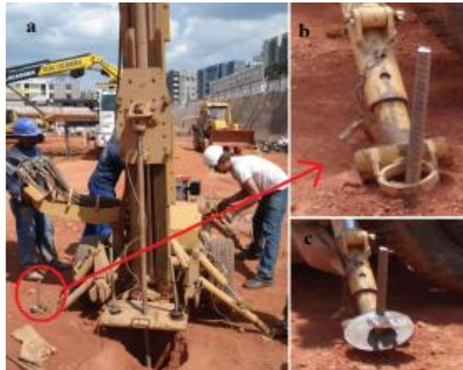
Figura 3.12 - Equipamento utilizado: a) Máquina de cravação, b) Ancoragem sendo instalada, c) Detalhe da ancoragem pronta
