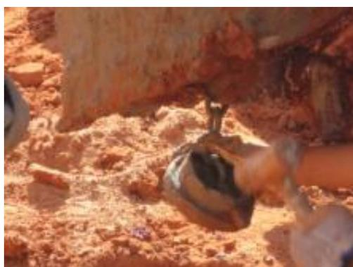
Figura 2.3 - Colocação da tampa no trado da hélice
