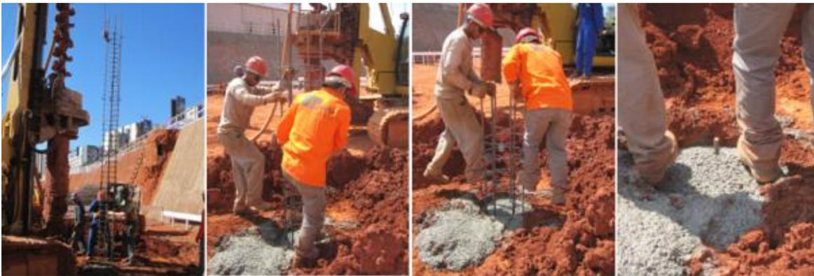
Figura 2.6 - Sequência de instalação da armação manualmente
