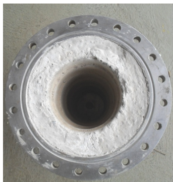
Figura B.19: Isolamento interno de argamassa refratária
