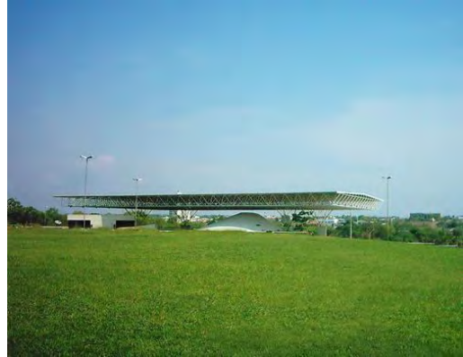
Fig. 5.24 Espaço Cultural construído na área verde lindeira ao Brejo Comprido. Fonte: Rodrigo Gonçalves Luz, 2009
