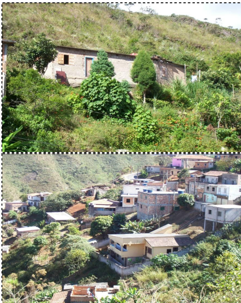
Fotos 48 e 49 – Respectivamente, moradia em área de risco no bairro São Cristóvão e conjunto de casas construídas em área de risco no bairro Santa Cruz. Fotos do autor / junho de 2010.
