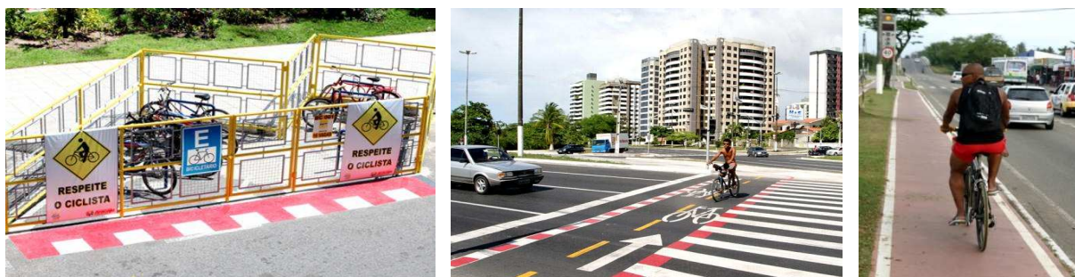
Figura 4.10: Bicletário, travessia e a ciclovia em canteiro central - Aracaju (PMA, 2011).
