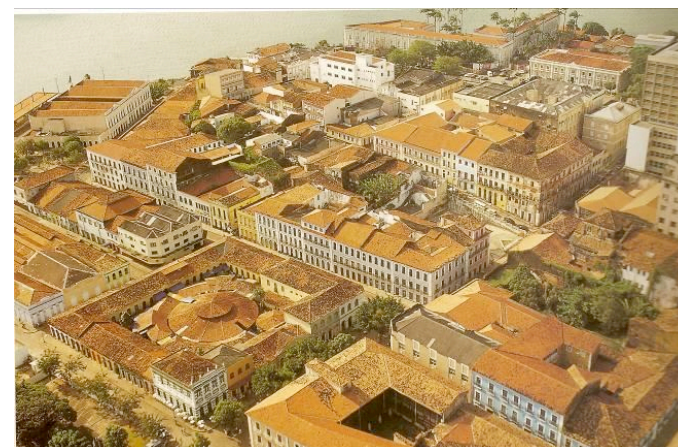
Fig. 3.44 – Bairro da Praia Grande – casa das telhas em 1º plano – São Luís/2000
