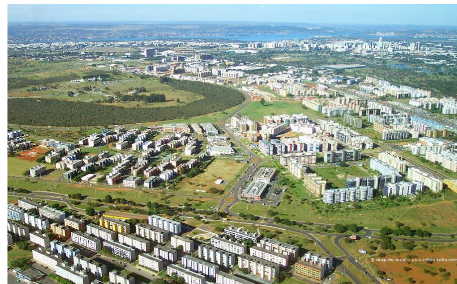
Fig. 2.45 - Cruzeiro Novo em 1º plano (4 pavt°); à direita, o Setor Sudoeste (6 pavt°); à esquerda, o "setor econômico" do Sudoeste (3 pavt°). Foto: Augusto César B. AREAL
