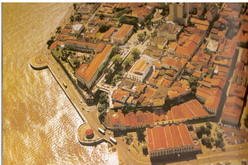
Fig. 3.28 – Vista do bairro da Praia Grande
