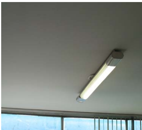
Figura 4.3 Luminária que atende aos requisitos de segurança, mas não aos de eficiência.
