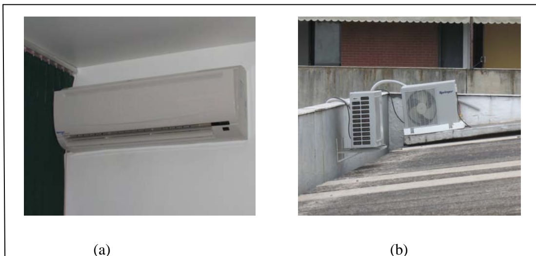
Figura 4.8 Conjunto de refrigeração tipo split : (a) unidade interna (evaporadora) e (b) unidade externa (condensador).
