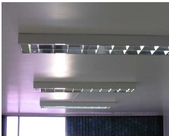
Figura 4.4 Luminárias que atendem aos requisitos de eficiência, mas não aos de segurança.
