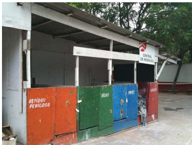
Foto 5: Área de separação de resíduos em canteiro da Santa Bárbara
